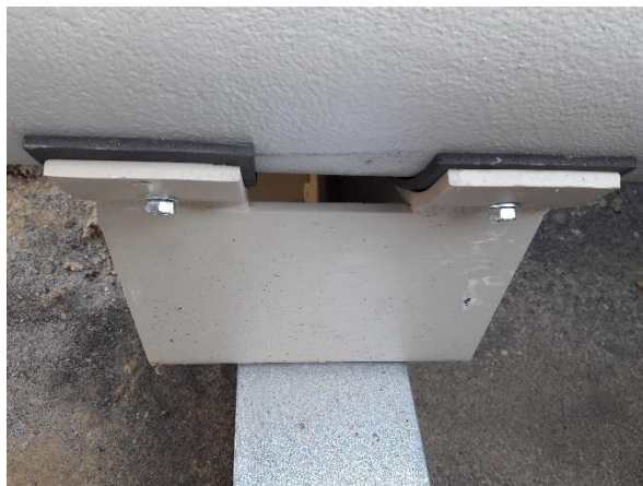
Slika 7: Zamenjava nosilcev in vgradnja drsnih podpor cevovoda (teflonski stik)
